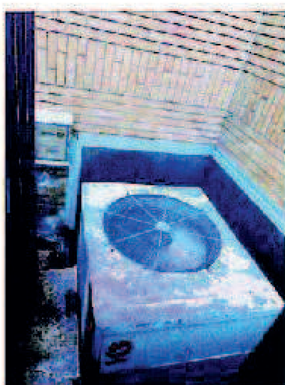
Gruppo di produzione caldo/freddo posto all'esterno dell'edificio
